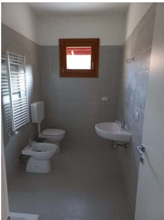
visuale del locale bagno prima e dopo i lavori
